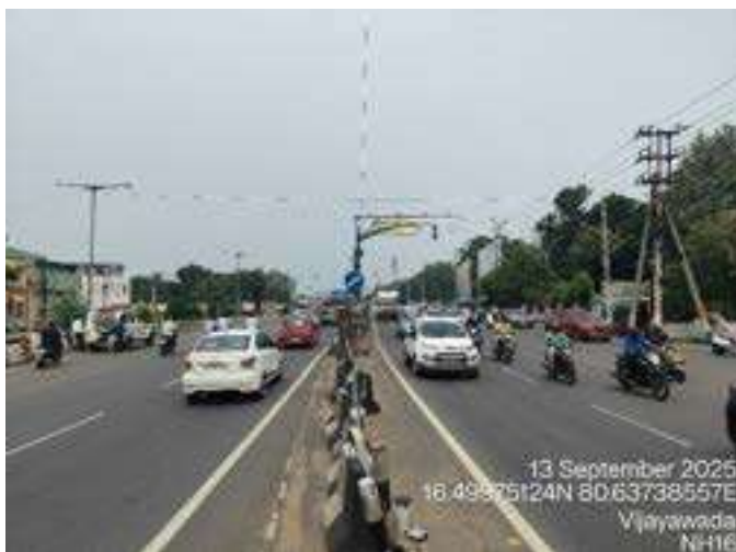
End Point (km 437.500)
