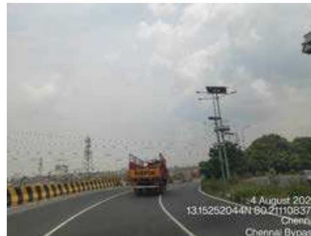
End Point (km 32.600)
